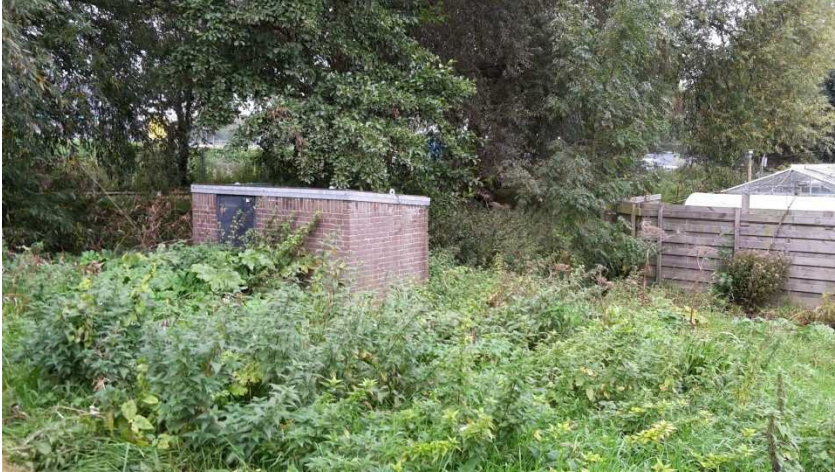
Foto 1 Behuizing bestaande gemaal Ons Buiten
