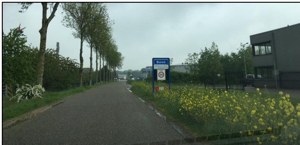
Figuur 4.4: Foto Erichemsewal bij het bedrijventerrein van Buren in het verlengde ligt de Lange Hofstedestraat
