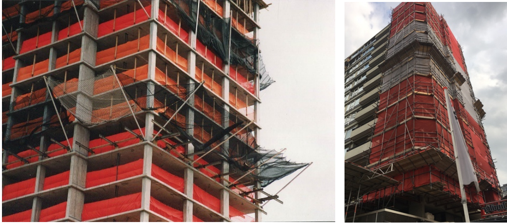
Figuur 3.4.3: voorbeeld vangconstructie lichte materialen, overkappingen bouwveiligheidszone
