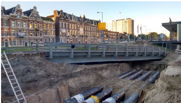
Figuur 4.3.3: mogelijk oplossing corrigeren verzakken warmteleidingen
