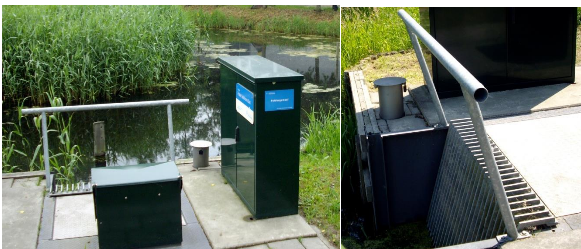
Figuur 3, Voorbeeld inlaatconstructie met schakelkast.
