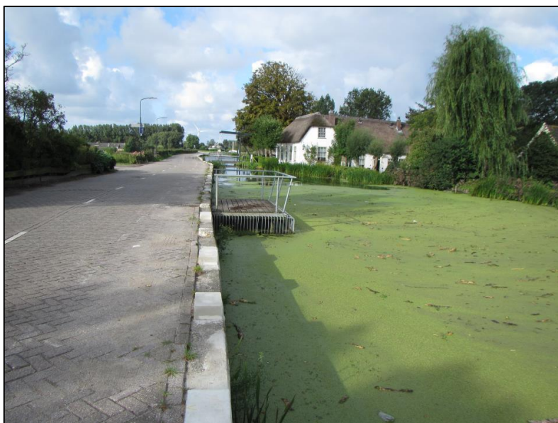
Foto, 2 bestaande inlaatconstructie.
