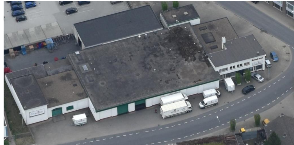
Bestaande karakteristieke bedrijfsgebouwen
