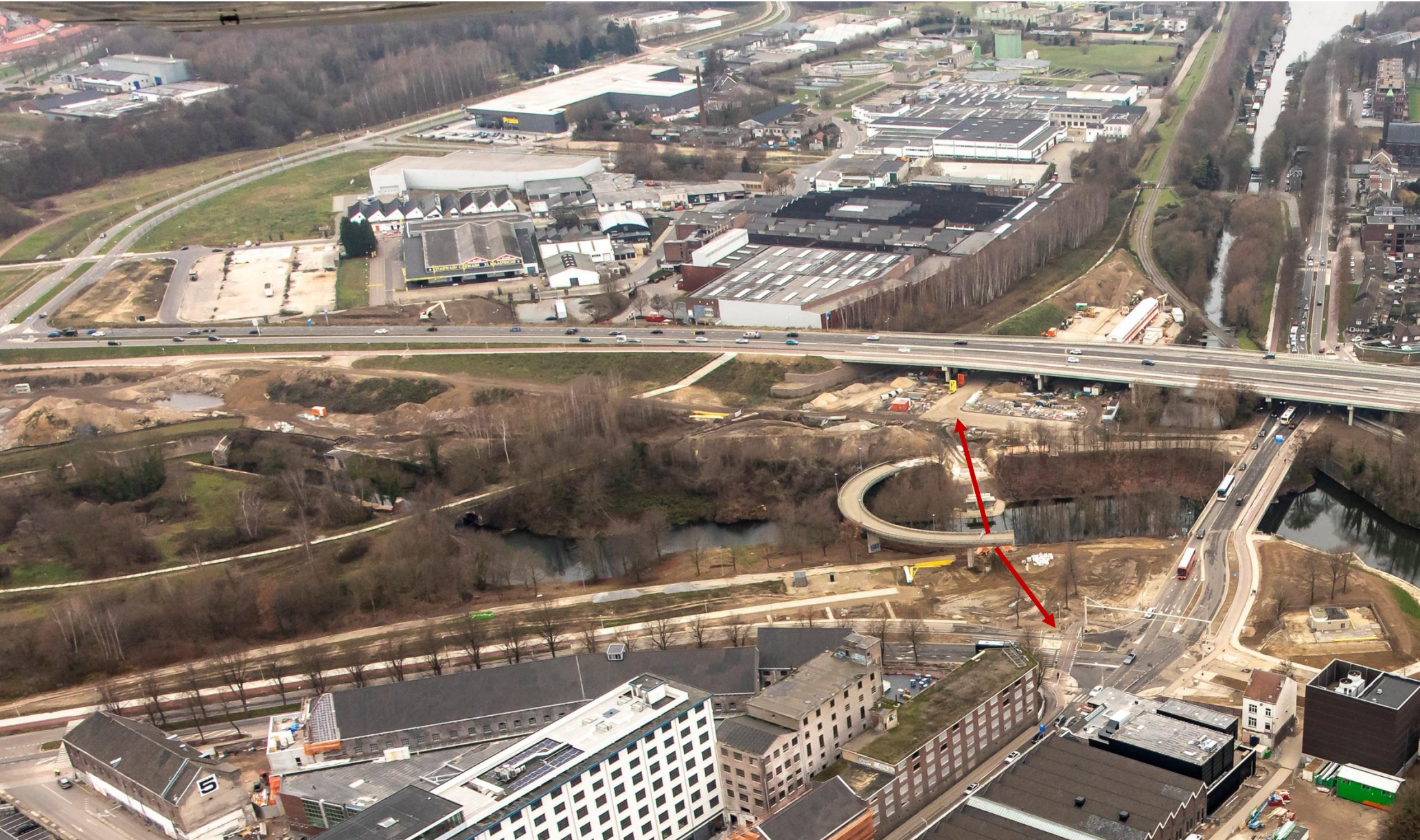
Foto jan 2019 bestaande situatie na aanleg aanlanding Noorderbrug, fietsroute kralensnoer in aanleg
