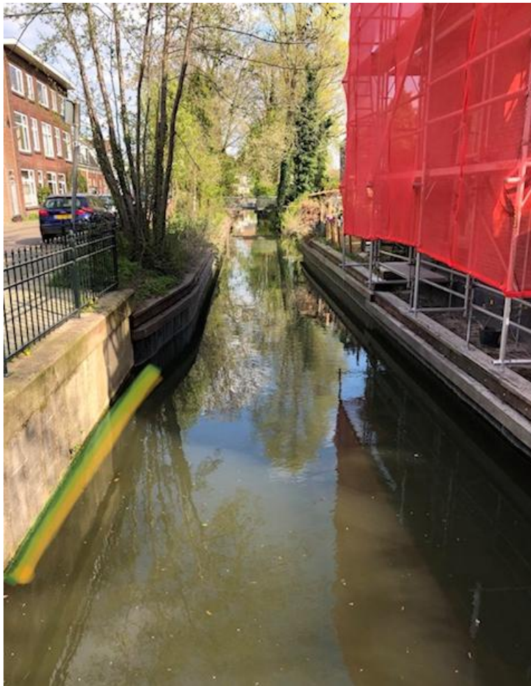
Betonnen beschoeiing met fauna uittreedplaats en met erachter langs een vegetatierand
