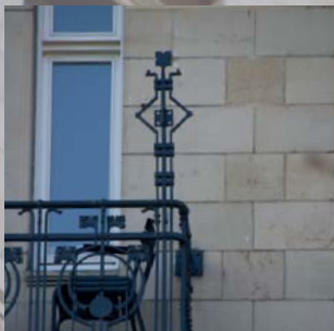
Detail van het smeedwerk op de erker.
