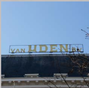
Benaming van de oorspronkelijke gebruikers op het dak.
