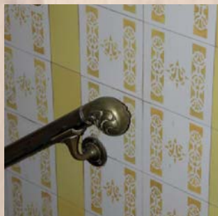
tegelwerk in het trappenhuis van de voormalige woning.
