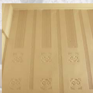
Aangebracht Art Deco sjabloonwerk in het stucwerk.
