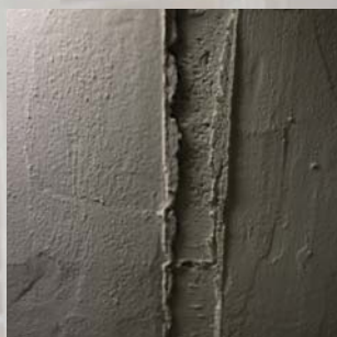
Betonwerk met stucwerk van de vloer in de kelder.
