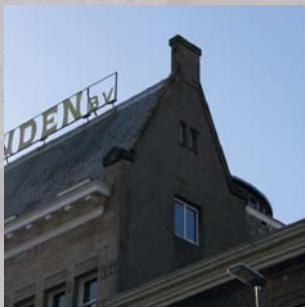
Rechterzijgevel en dakvlak.
