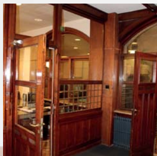
Doorgang tussen de kantoren tussen beide hoofdtrouwen.
