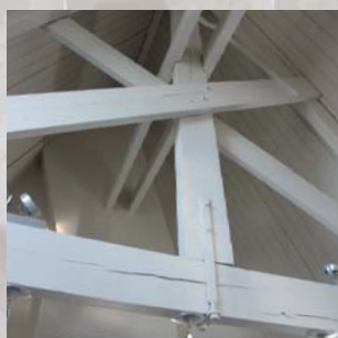
Kapconstructie voorzien van schoorwerk.
