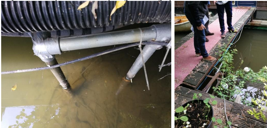
Objecten in of op het water: loopbrug en 6 steigerpalen
