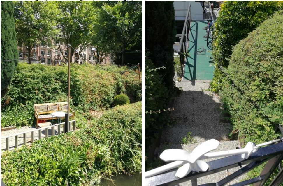
Bebouwing op talud: tegels, loopbrug, palen en hekwerken
