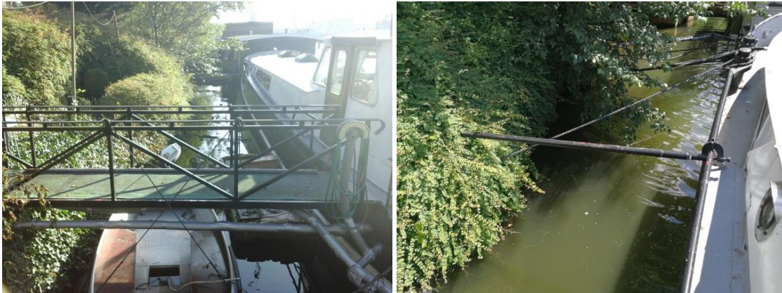
Aanmeerconstructie: afstandhouders met kabels/touw
