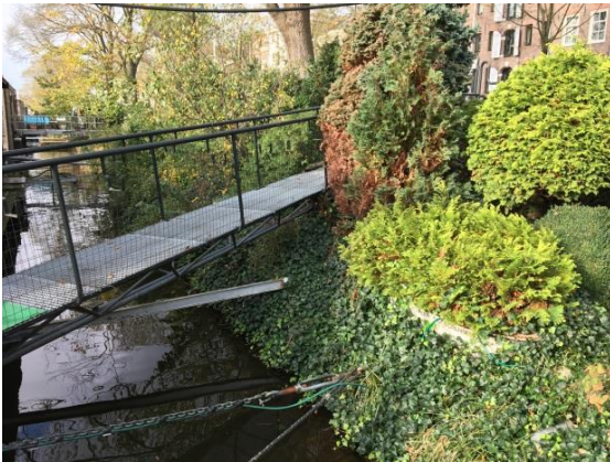
Aanmeer constructie: afhouders met kabels/touwen
