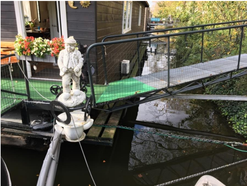
Aanmeer constructie: afhouders met kabels/touwen
