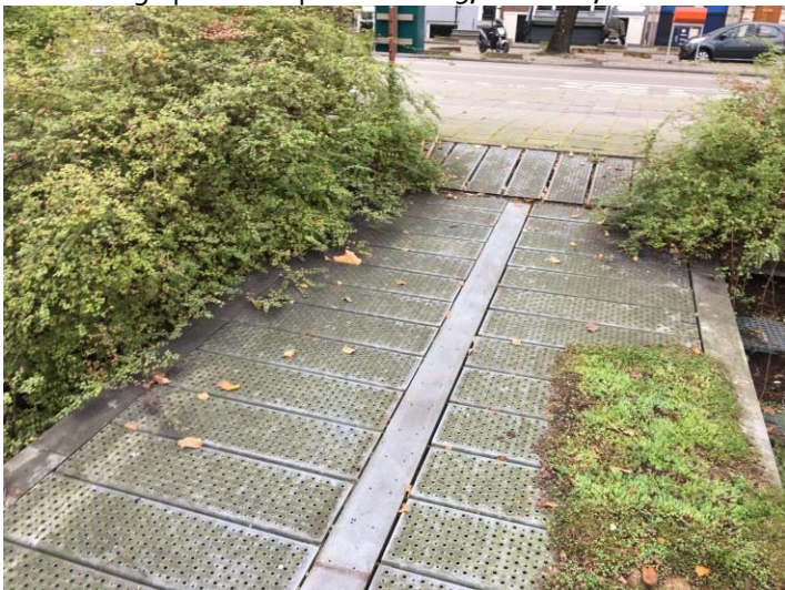
Bebouwing op talud: 2 palen HEA 25, vlonders, bomen en struiken
