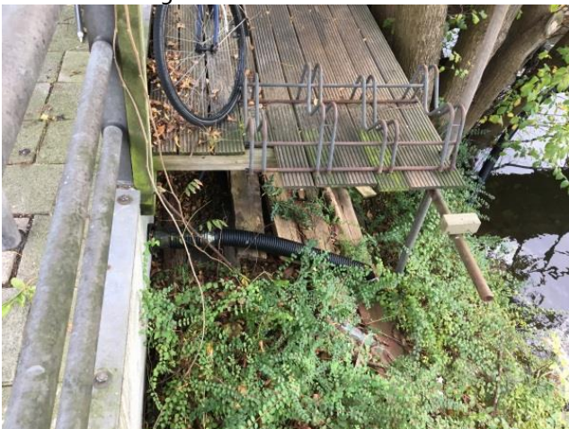
Nutsvoorzieningen oever: vanuit betonnen keerwand en talud
