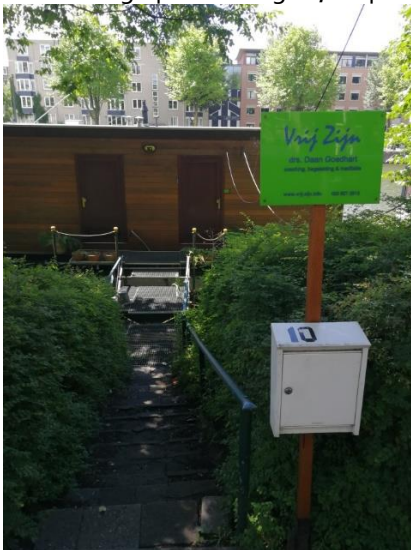
Bebouwing op talud: tegels, loopbrug, bomen en struiken
