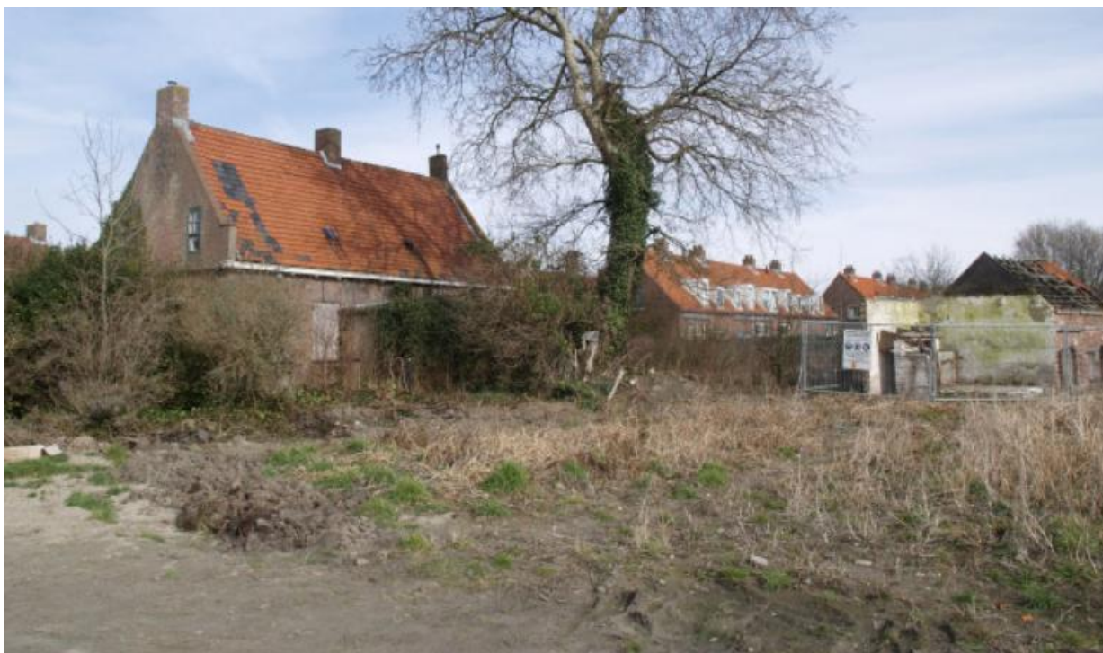
Figuur 35: Gevolgen van sloopwerkzaamheden in het onderzoeksgebied in 2009.
