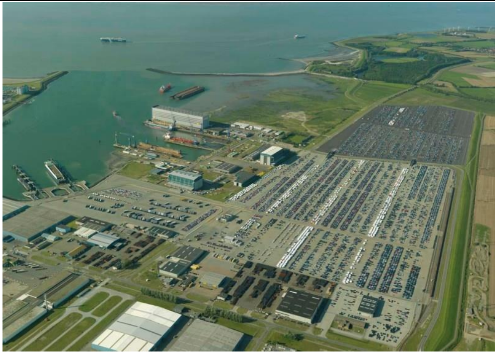
Figuur 1 Luchtfoto van C.RO-terrein te Vlissingen.
