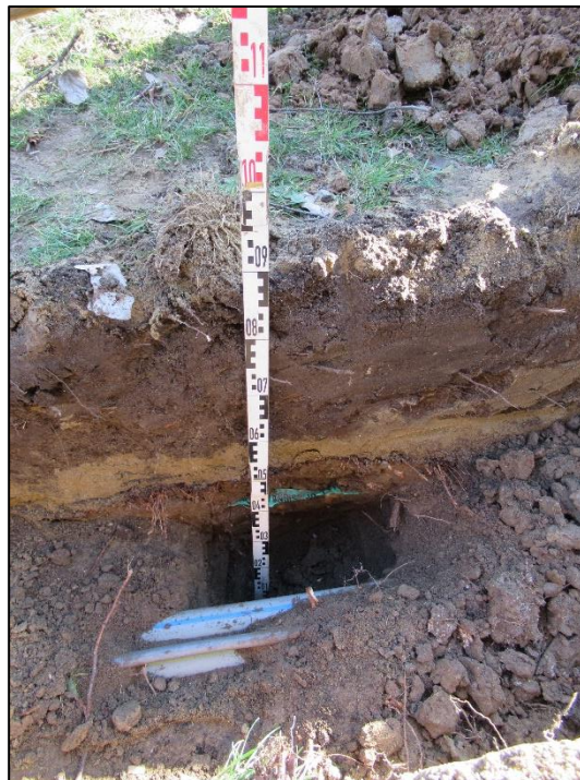
Kabels en/of leidingen aangetroffen bij boom 11 op 60 – 70 cm beneden maaiveld
