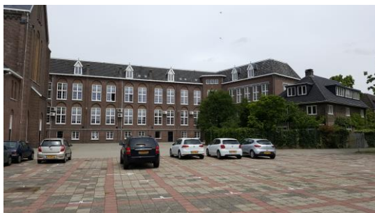
Rechter deel achtergevel (1916/1917/1958)
