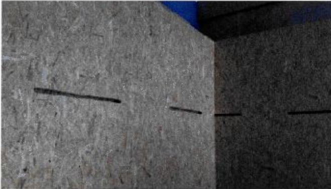
Figuur 27. Winterverblijfsvoorziening (in aanbouw) in het provinciehuis in Zwolle met de verbindingsspleten tussen de ruimten.
