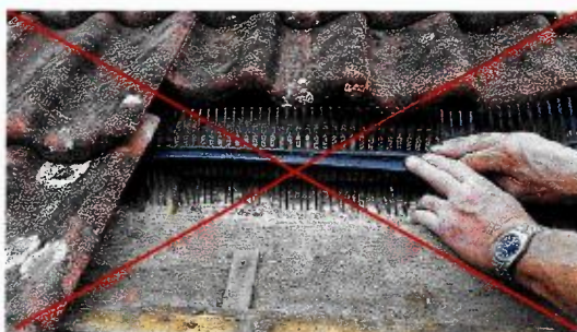
Figuur 3.3 Bij zachte isolatieplaten moet een folie worden toegepast om schade te voorkomen.
