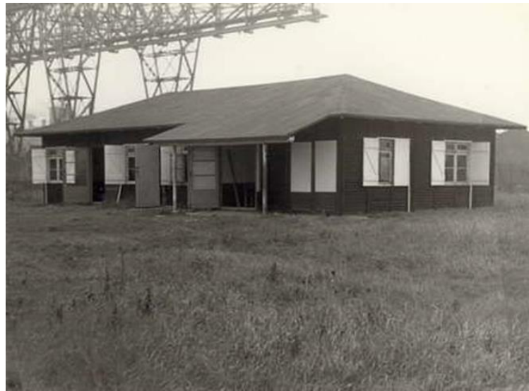
1 Willem de Zwijgergroep, op het terrein waar nu de Benelux tunnel is.
