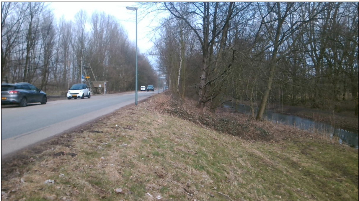
Afbeelding 5: het talud langs de Watersportweg waar een kiss & ride-zone is gepland.
