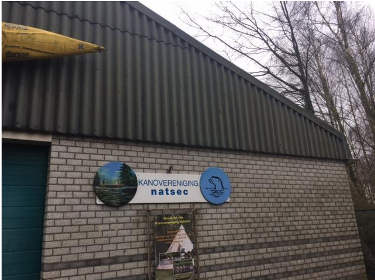
Afbeelding 4.5 geschikt (tijdelijke) verblijfplaats vleermuizen onder gevelbeplating gebouw
