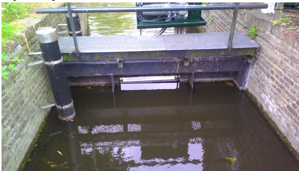
Figuur 1: Stuw aan het Rietveld
