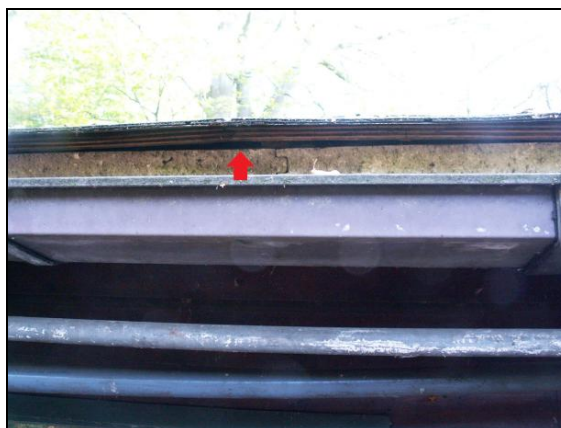
Spleet tussen bouwplaten met singels en de isolatieplaten.
