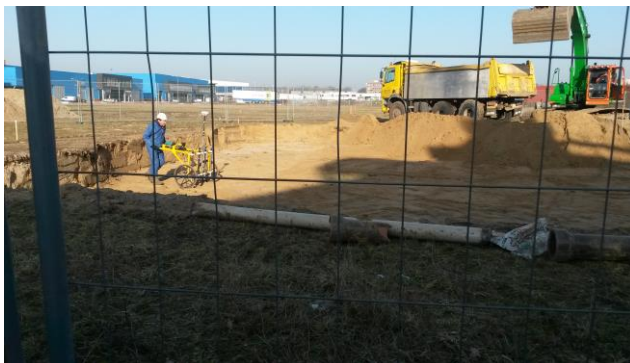
Ontgraving eerste meter en NGE onderzoek
