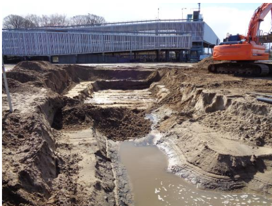
Overzicht ontgraving aanvullende wand
