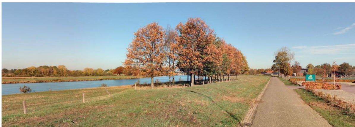
Figuur 12 Bestaande kering langs de weg Ouddorp
