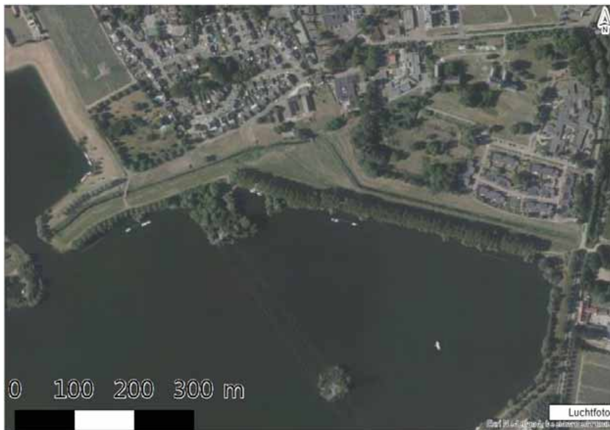
Afbeelding 4.4 Detail van afbeelding 4.2. Langs de Noorzijde van de Polderveldplas zijn mogelijkheden tot het versterken van een alternatieve vliegroute aanwezig in de vorm van begroeiing en lijnvormige objecten in de vorm van bebouwing.
