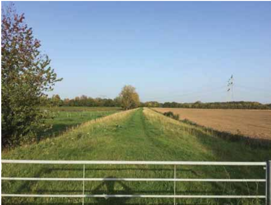
Afbeelding 79. De bestaande dijk aan de oostelijke zijde van Pol gezien in oostelijke richting.
