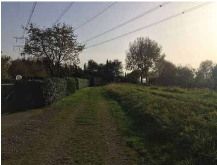
Afbeelding 76. De bestaande dijk gezien in zuidelijke richting.
