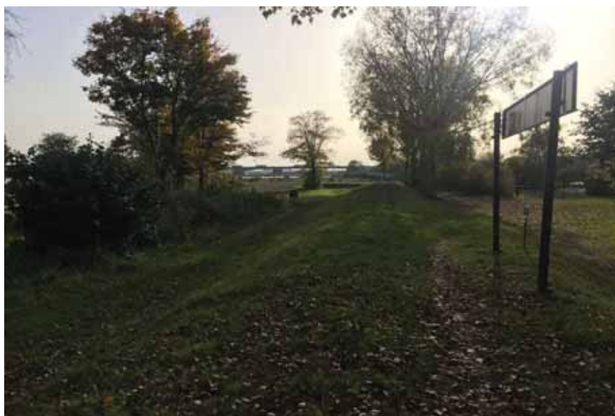
Afbeelding 71. De bestaande dijk aan de achterzijde (westelijke zijde) van Pol gezien in zuidelijke richting.
