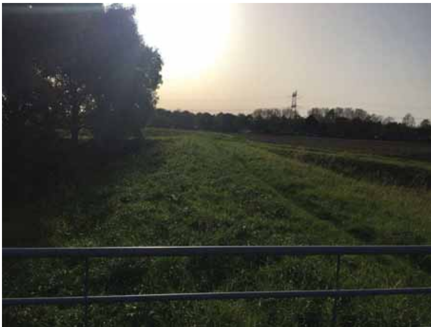
Afbeelding 80. De bestaande dijk aan de oostelijke zijde van Pol gezien in westelijke richting.
