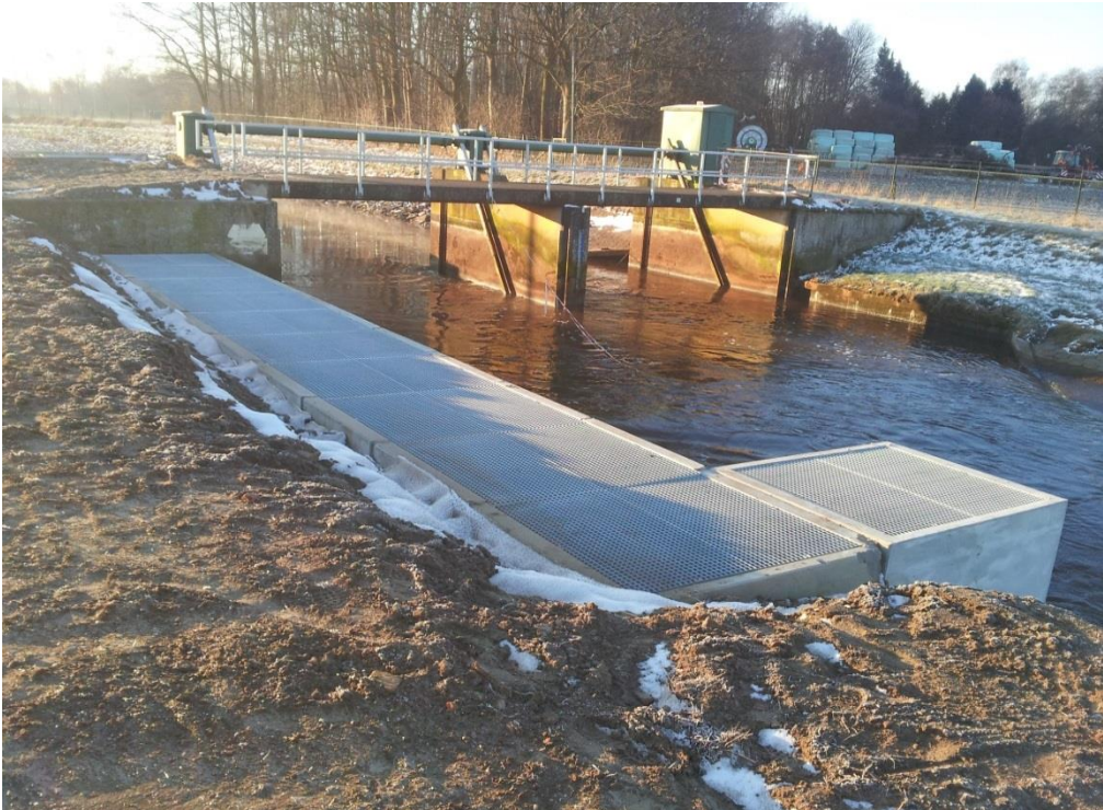
Figuur 9. Referentiefoto van een De Wit-vispassage langs een stuw, in dit geval in de Aa bij Veghel (bron: waterschap Aa en Maas)
