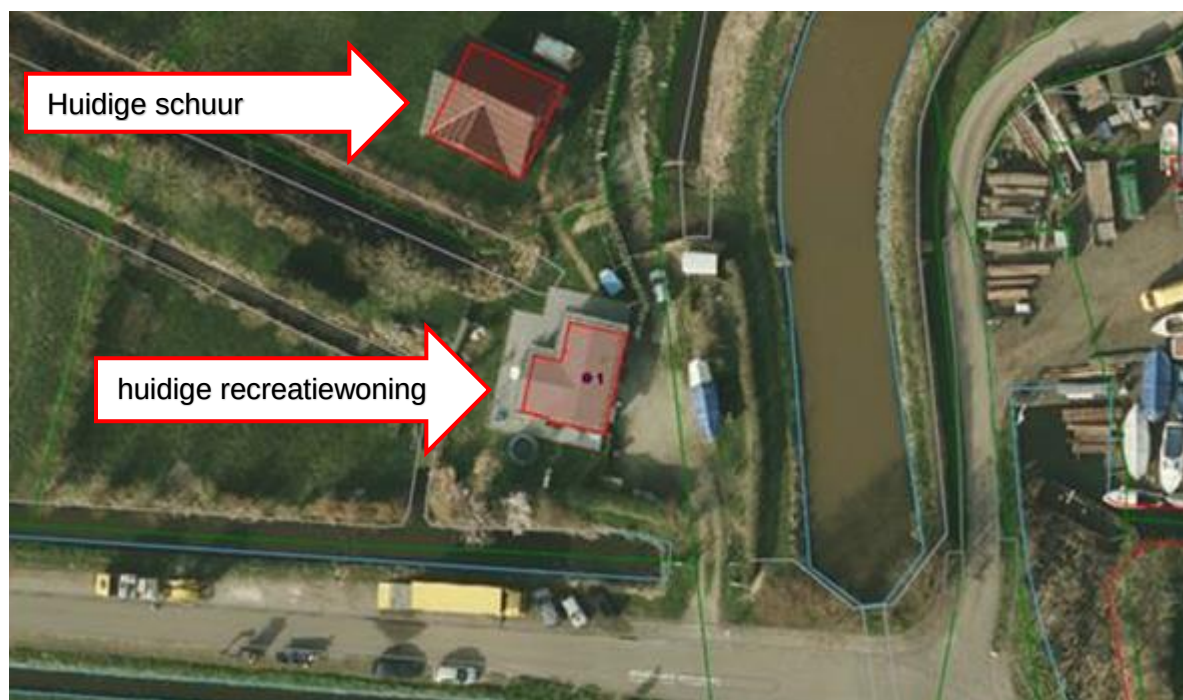
Luchtfoto met bebouwingkaders van de schuur en recreatiewoning
