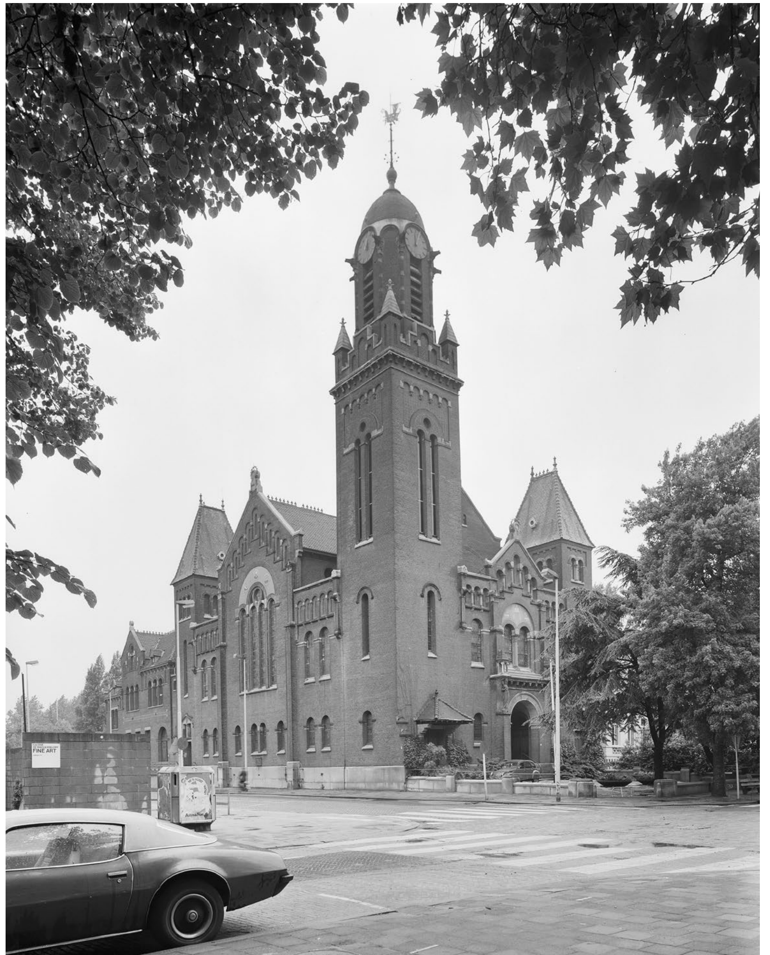
Zicht op het voorplein van de Remonstrantse kerk, 1979. Het hek is grotendeels verwijderd en de inrichting van het plein is drastisch veranderd. Bron: RCE.
