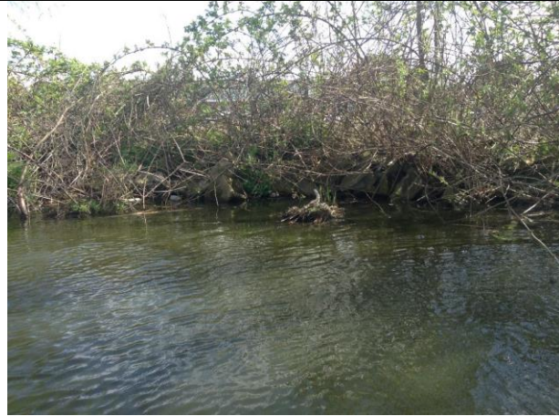
inspectie vooroever , foto(09 van 24)
