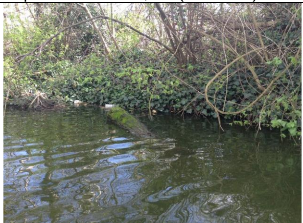
inspectie vooroever , foto(18 van 24)
