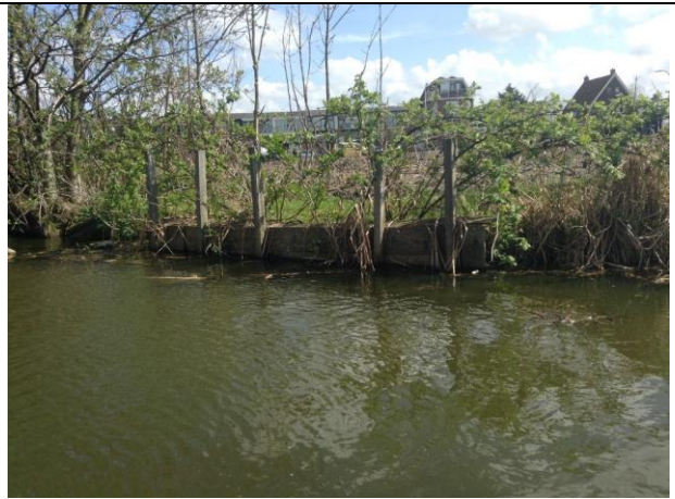
inspectie vooroever , foto(08 van 24)
