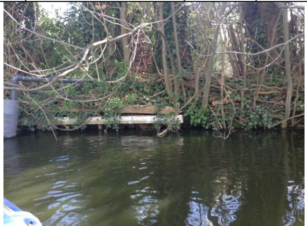
inspectie vooroever , foto(12 van 24)
