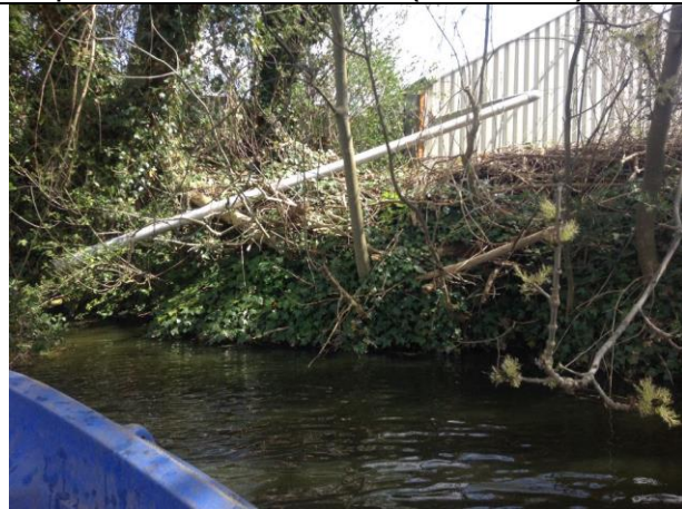
inspectie vooroever , foto(11 van 24)
