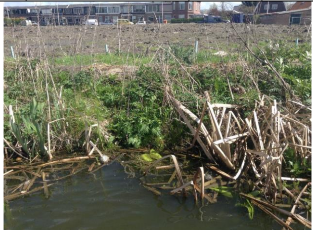
inspectie vooroever , foto(04 van 24)
