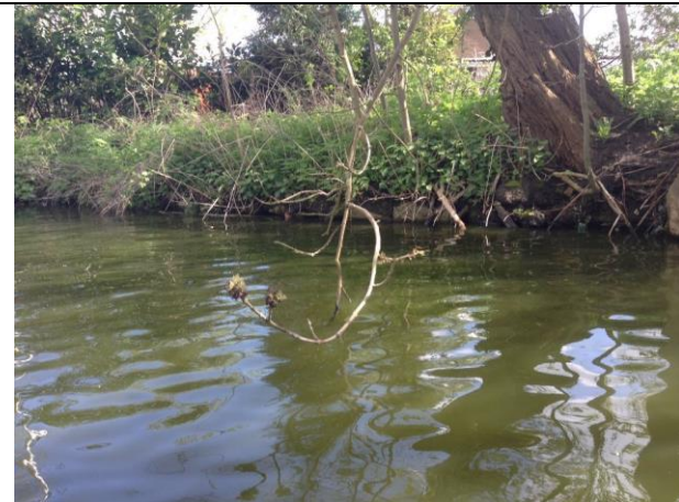
inspectie vooroever , foto(19 van 24)
