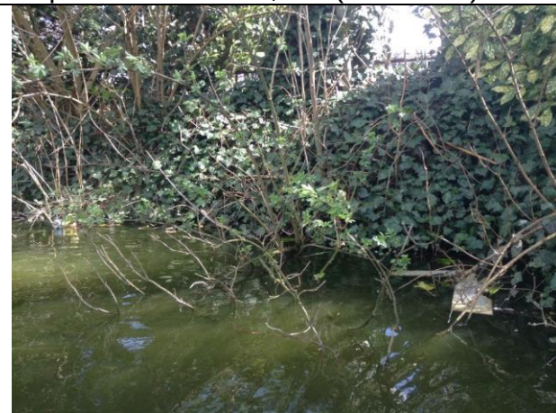
inspectie vooroever , foto(15 van 24)
