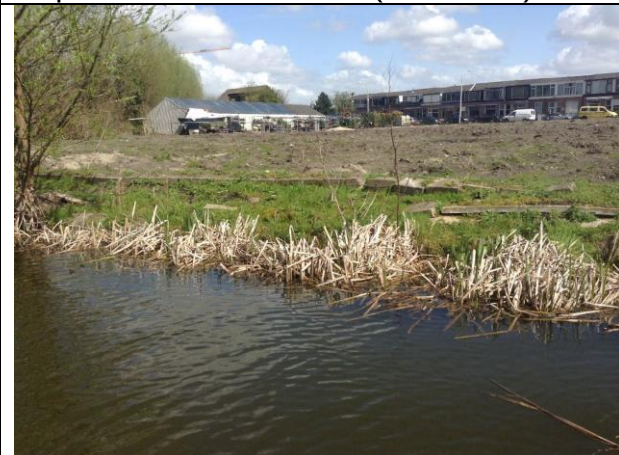
inspectie vooroever , foto(05 van 24)
