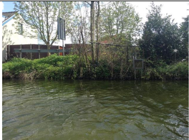
inspectie vooroever , foto(20 van 24)
