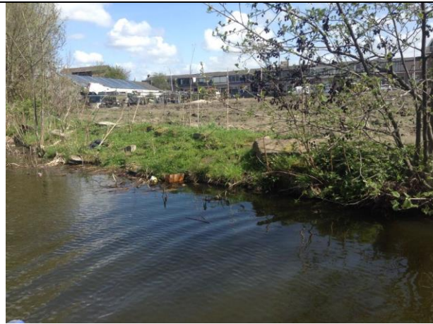
inspectie vooroever , foto(07 van 24)
