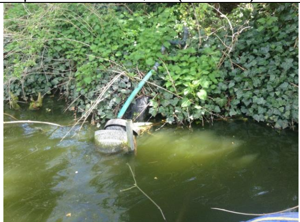
inspectie vooroever , foto(16 van 24)
