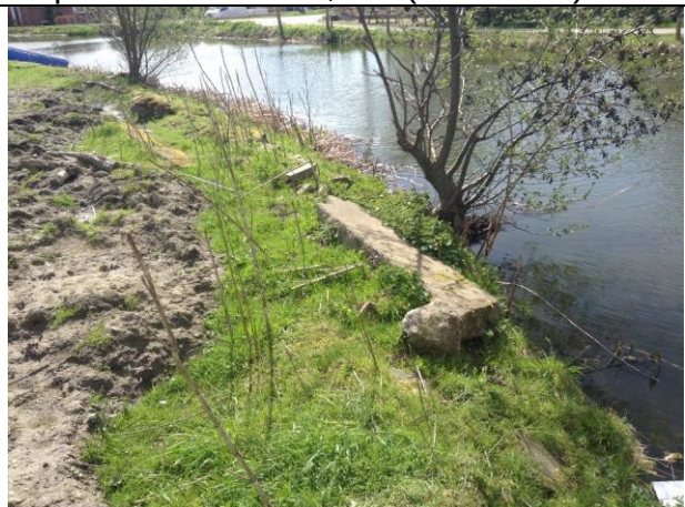
inspectie vooroever , foto(24 van 24)
