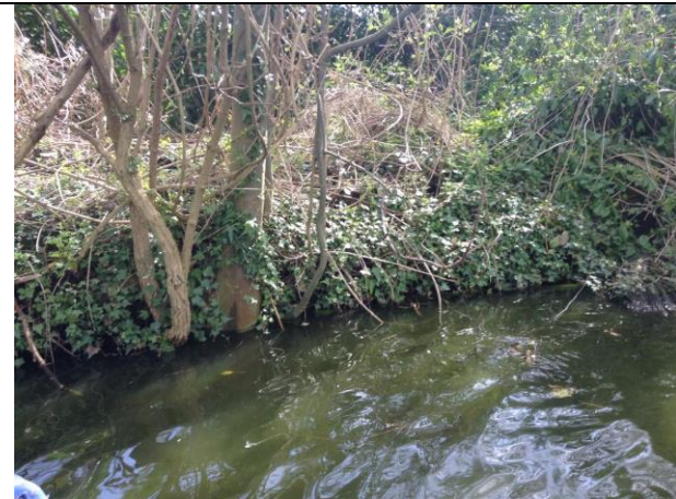
inspectie vooroever , foto(13 van 24)
