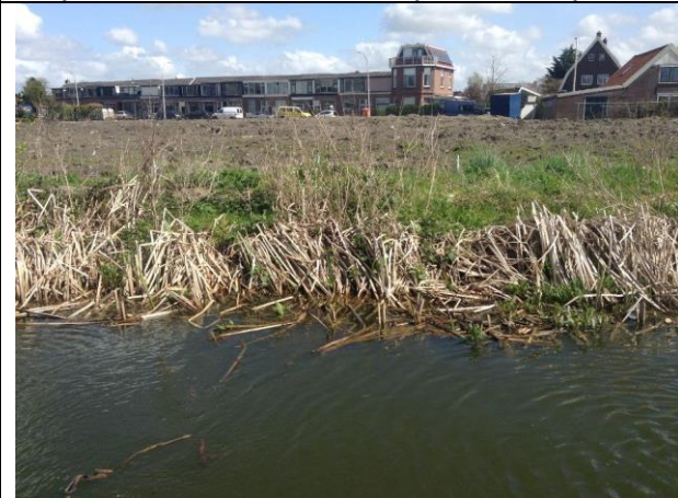
inspectie vooroever , foto(03 van 24)
