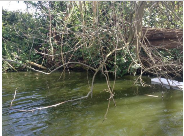
inspectie vooroever , foto(14 van 24)
