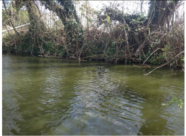
inspectie vooroever , foto(10 van 24)
