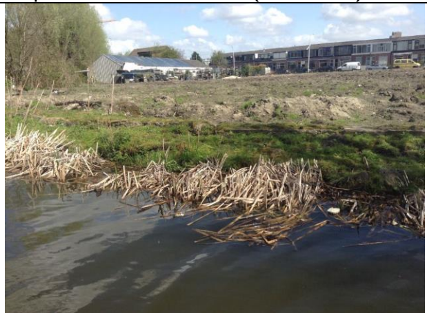
inspectie vooroever , foto(06 van 24)
