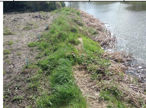
inspectie vooroever , foto(21 van 24)
