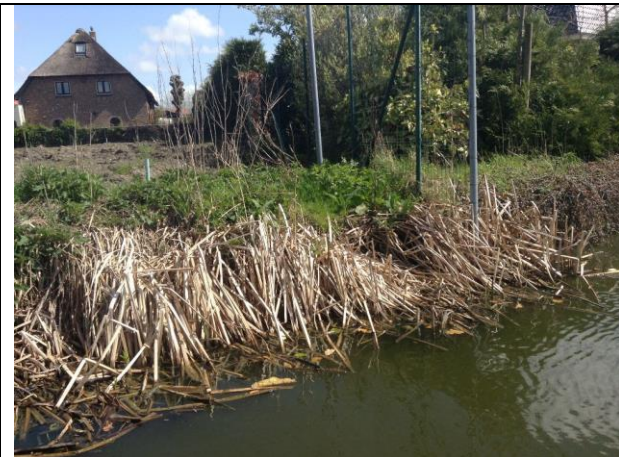
inspectie vooroever , foto(01 van 24)
