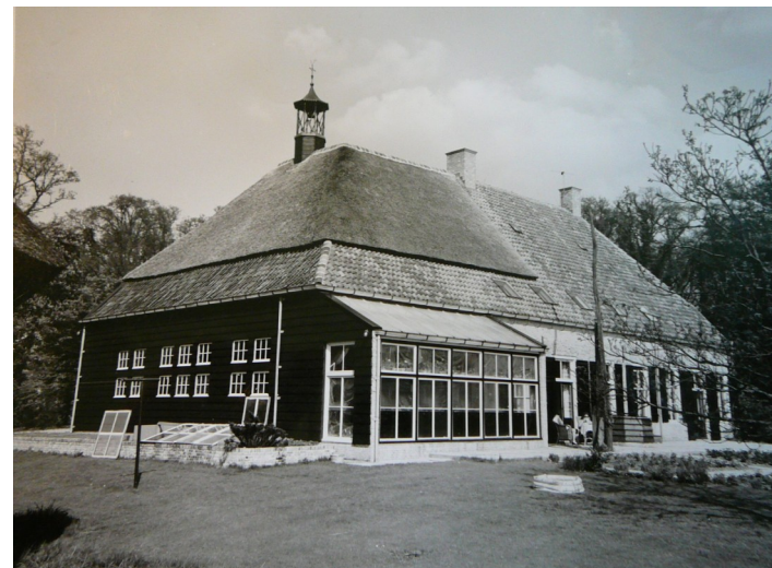
Afb. 5.7 Achterzijde van het huis met schuur en de nieuwe orangerie net na de restauratie in 1968.
