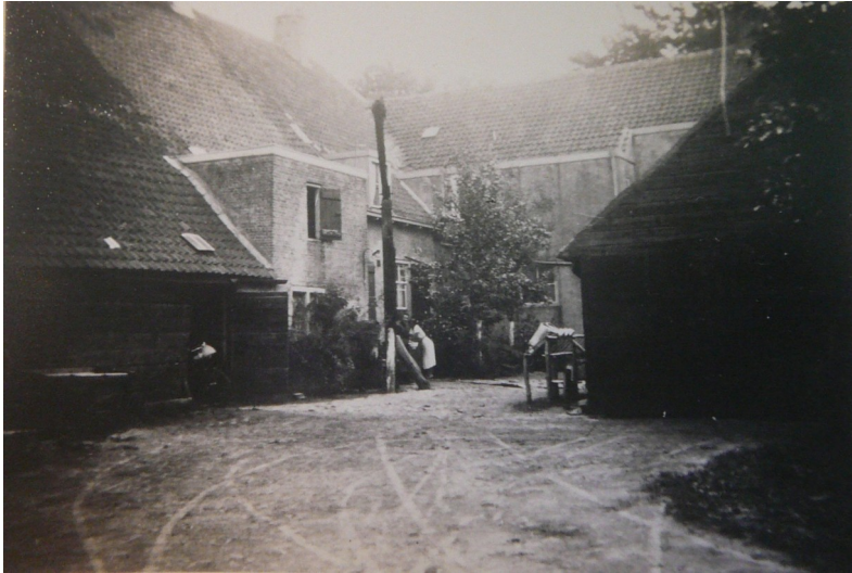
Afb. 5.4 Begin jaren 30 van de vorige eeuw met de achterzijde van het huis met achteraanbouw, waterput en schuur.
