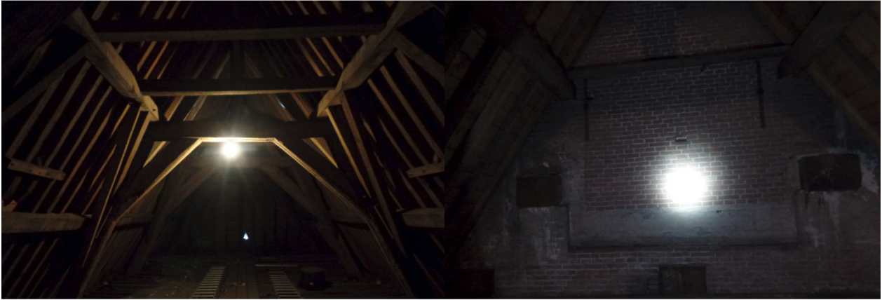
Afbeelding 11 en 12: inspectie van het kerkgebouw, er werden geen indicatoren gevonden die wijzen op mogelijk gebruik door vleermuizen.
