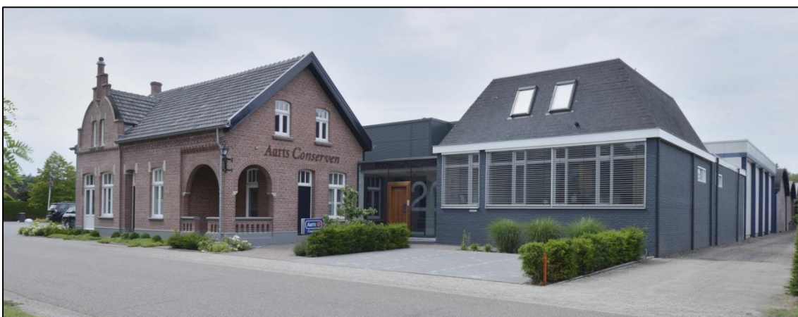
Foto vooraanzicht bedrijfslocatie met kantoorgebouw en daarachter gelegen bedrijfsgebouwen
