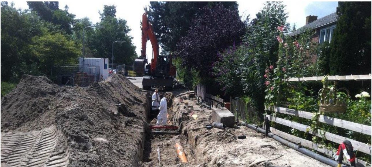
Figuur 8 - Aanleg van een gescheiden stelsel in Landsmeer (Bron: gemeente Landsmeer)
