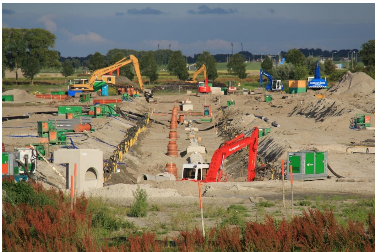
Rioolwerkzaamheden Baansteede-Noord Purmerend
