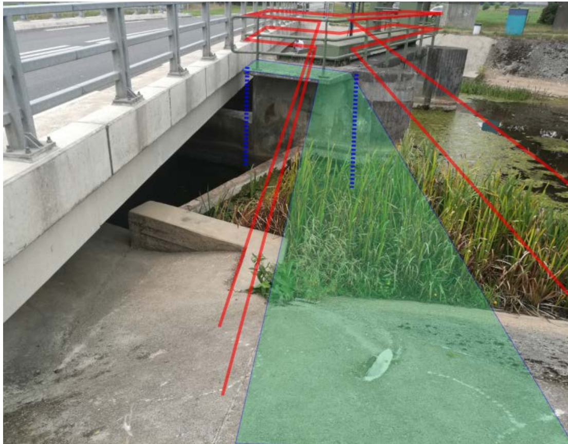
Figuur 4.9 Positie nieuwe peilbuizen zuidelijke pijler
