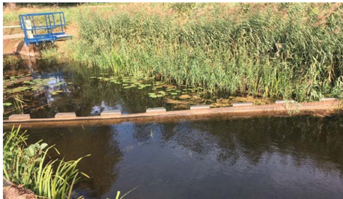
Figuur 3.2 Bolina-boom drijverlijn Dortherbeek
