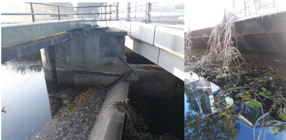
Figuur 4.2 Bestaande klep met eenzijdige ophanging en vaste straalbrekers
