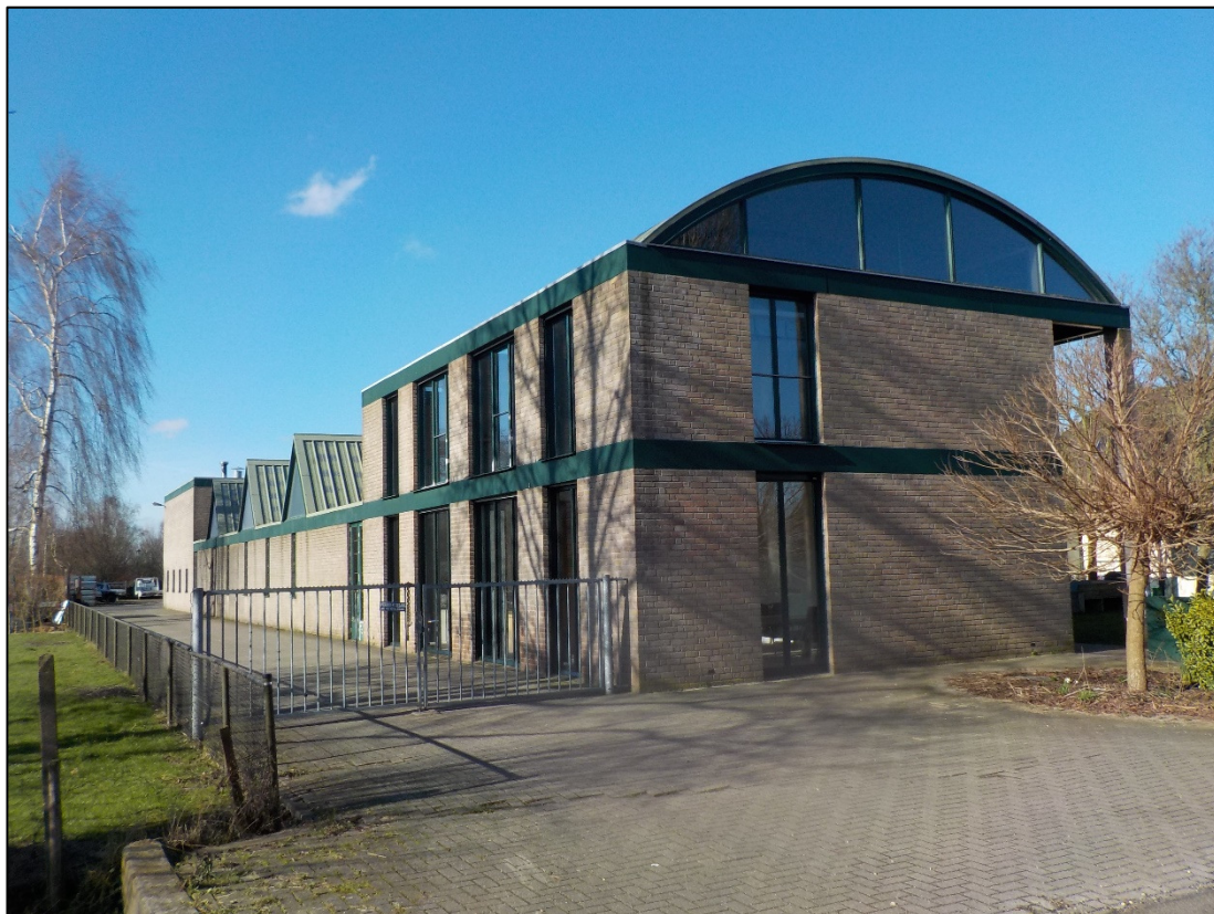
Afbeelding 12: Bedrijfspan, locatie boring 1 t/m 5
