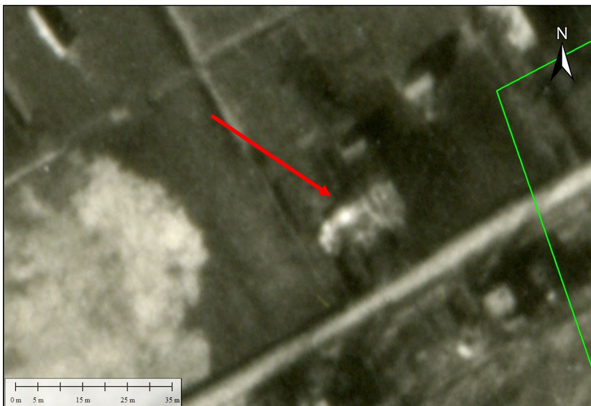
Figuur 27. Op deze luchtfoto van 24 februari 1944 is het huis zwaar beschadigd. Luchtfotonummer 4364.
