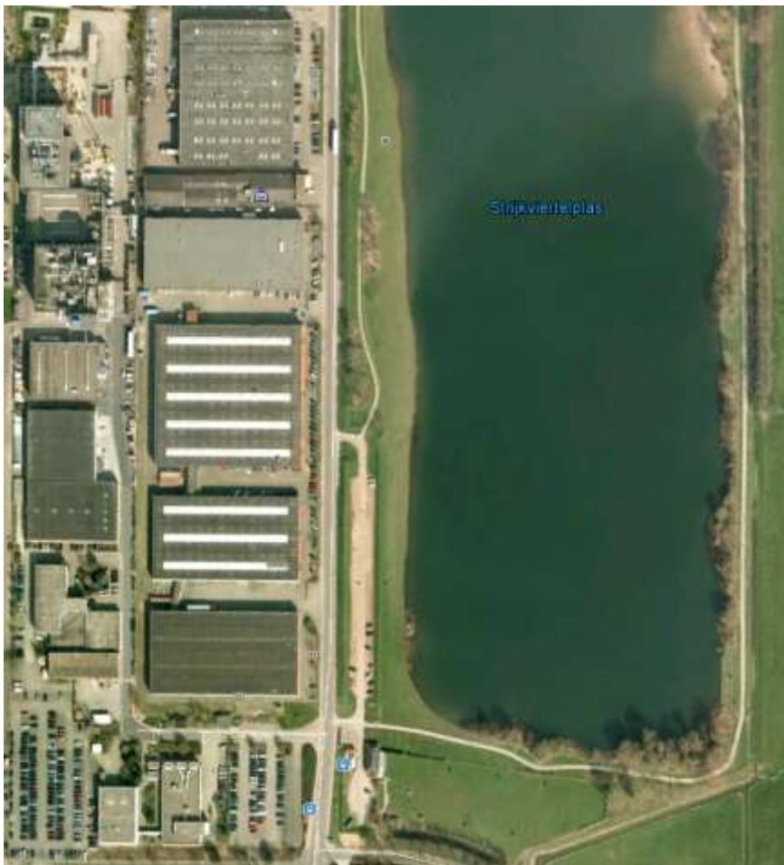
Figuur 1: overzichtsfoto locatie BASF Nederland B.V. - locatie De Meern (bron: Google maps)
