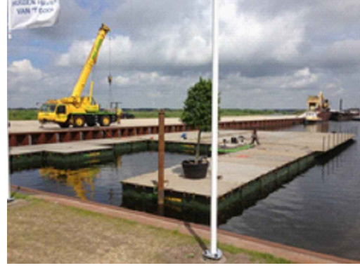
Voorbereidingsfase van de bouw van de brug.
