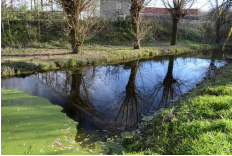
Foto 1: Westelijk gedeelte Kanjel (met schot- balk ter hoogte van het scouting-terrein aan de Ankerkade)
