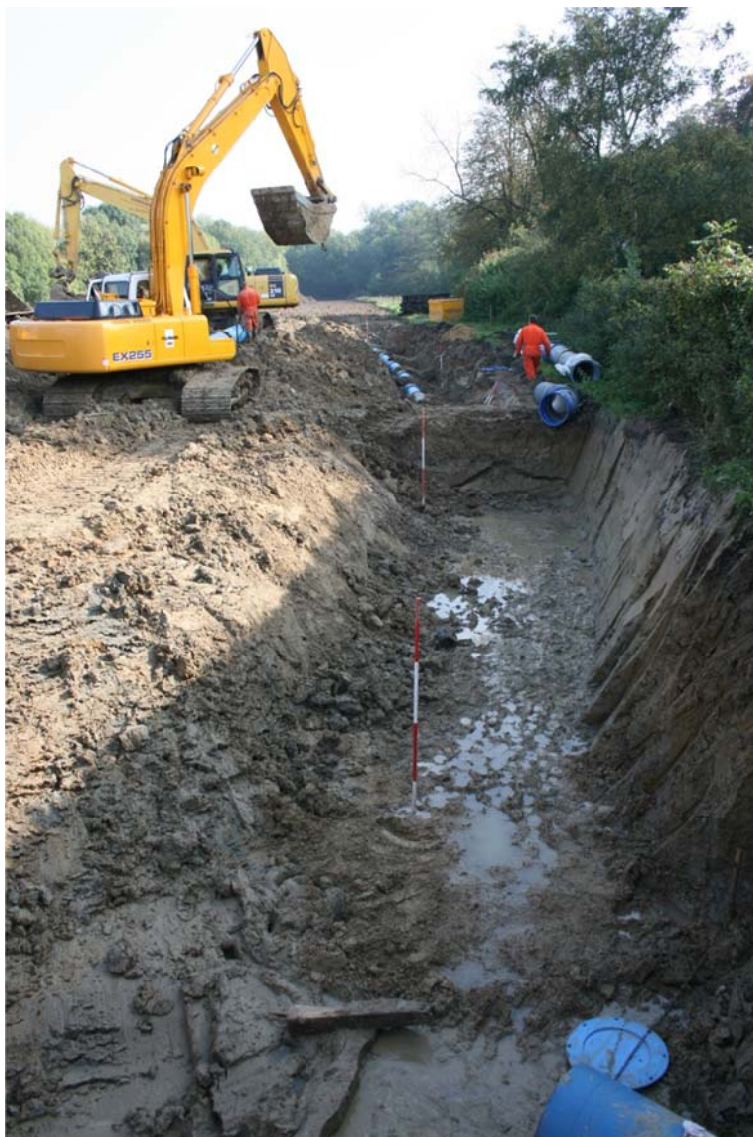
Afbeelding 10: Graafwerkzaamheden in het plangebied ten behoeve van de aanleg van de watertransportleiding.
