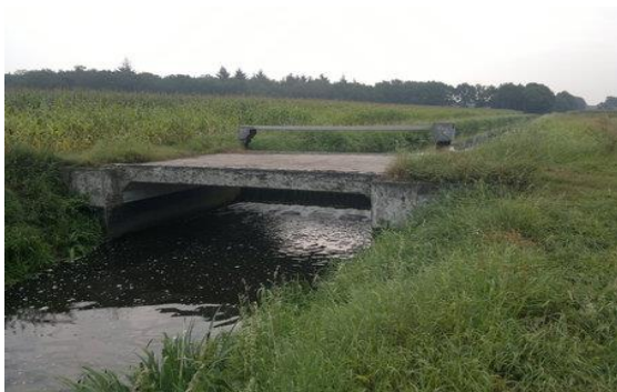
Figuur 4 stuw 261BC (benedenstrooms)
