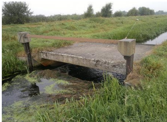
Figuur 3 stuw 261BB (benedenstrooms)
