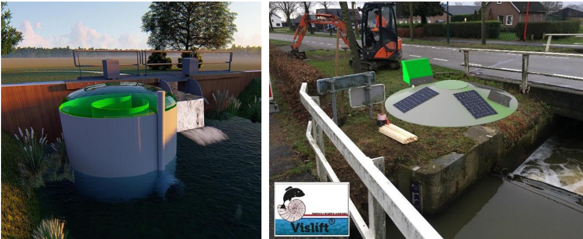
Figuur 3. Visualisatie van de Smart Vislift. Links een impressie van de vorm en het binnenwerk, rechts de situering op de projectlocatie bij de Leijgraaf.
