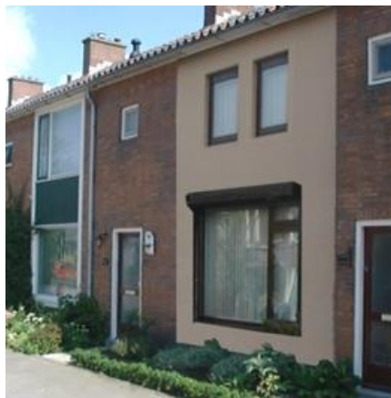
Niet passend door afwijkend materiaal- en kleurgebruik
