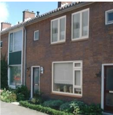
Niet passend door afwijkende indeling
