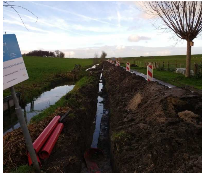
Sleuf voor elektriciteitskabel AWTG Rijnsaterwoude
