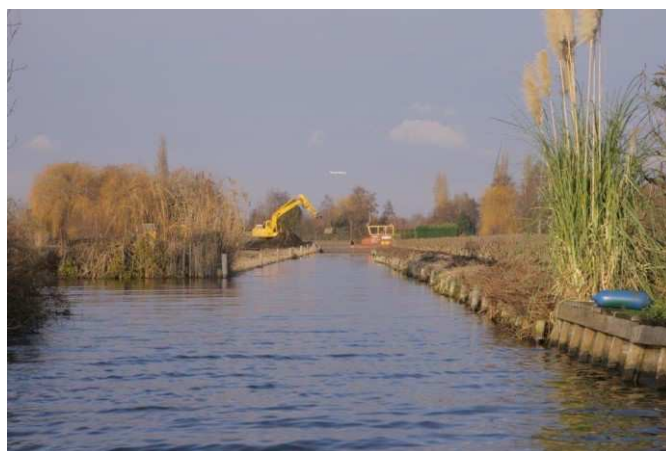
Werkzaamheden in KRW waterlichaam De bovenlanden
