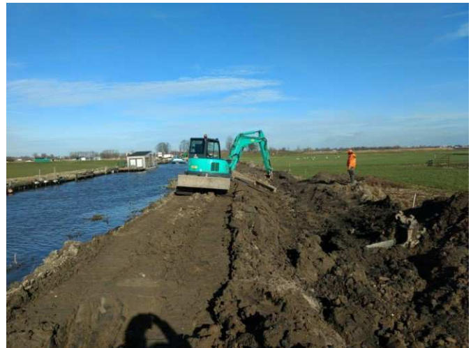
Kadeversterking Hemmeerpolder (regionale kering) in uitvoering
