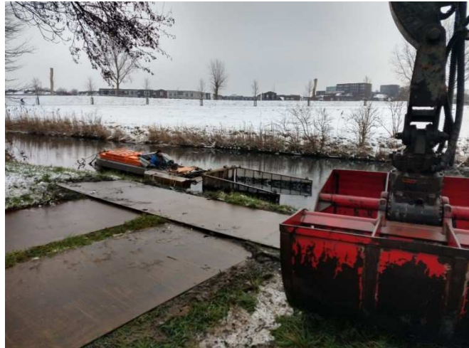
Eerste herstart van het baggerwerk in de Haarlemmermeer
