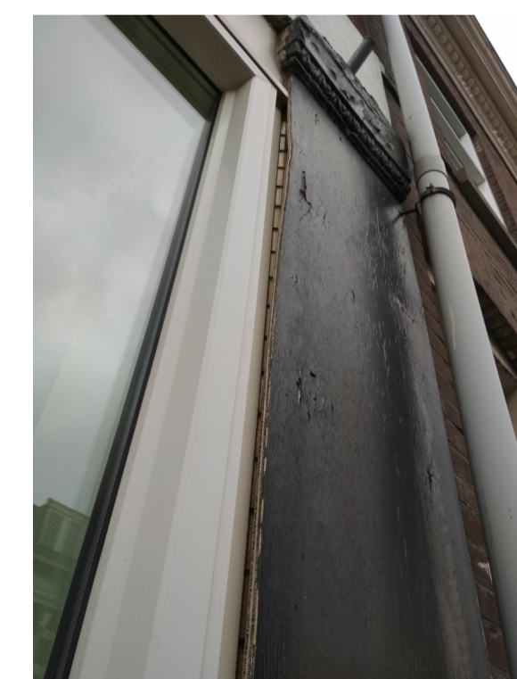
geglazuurd metselwerk achter mdf
