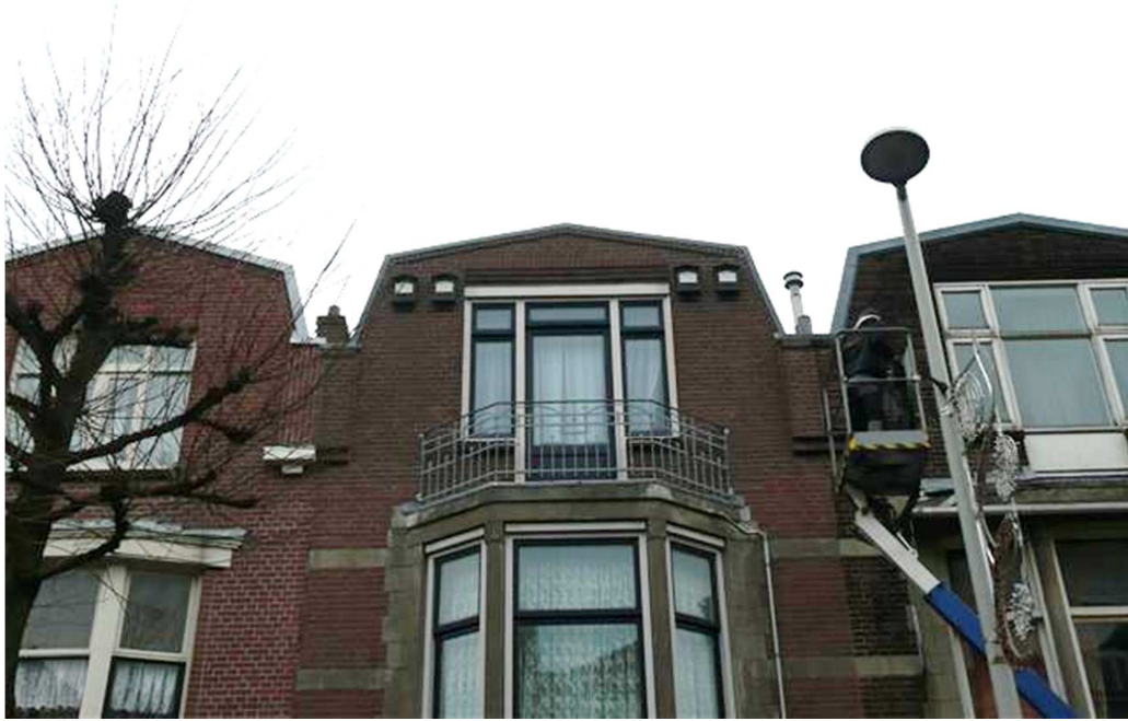
Figuur 2: eindsituatie na montage
