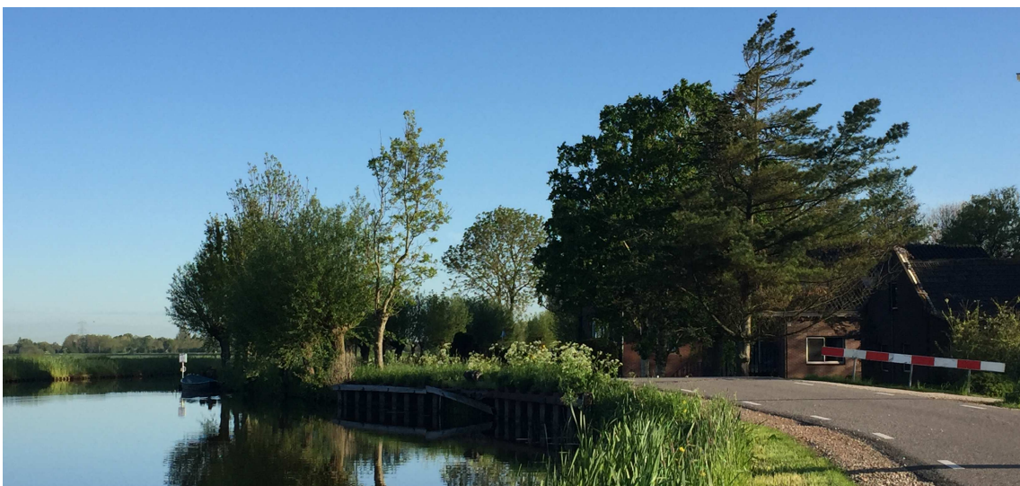
Afb. 2.6: damwand bij oude kruisende waterleiding
