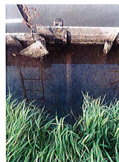
Eindbuis onderwater zichtbaar
