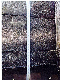
Meting bovenkant eindbuis tot waterlijn
